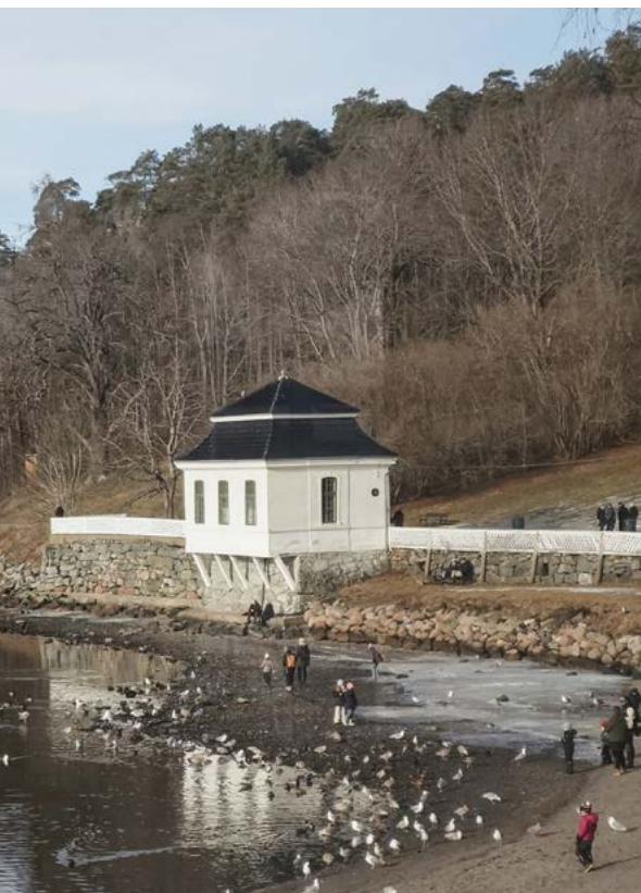
Historiske murer har stor verdi. Hvervenbukta
