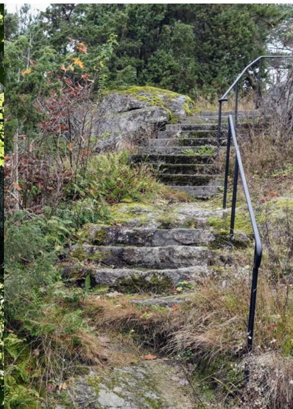
Hagetrapp med smijernsrekkverk
