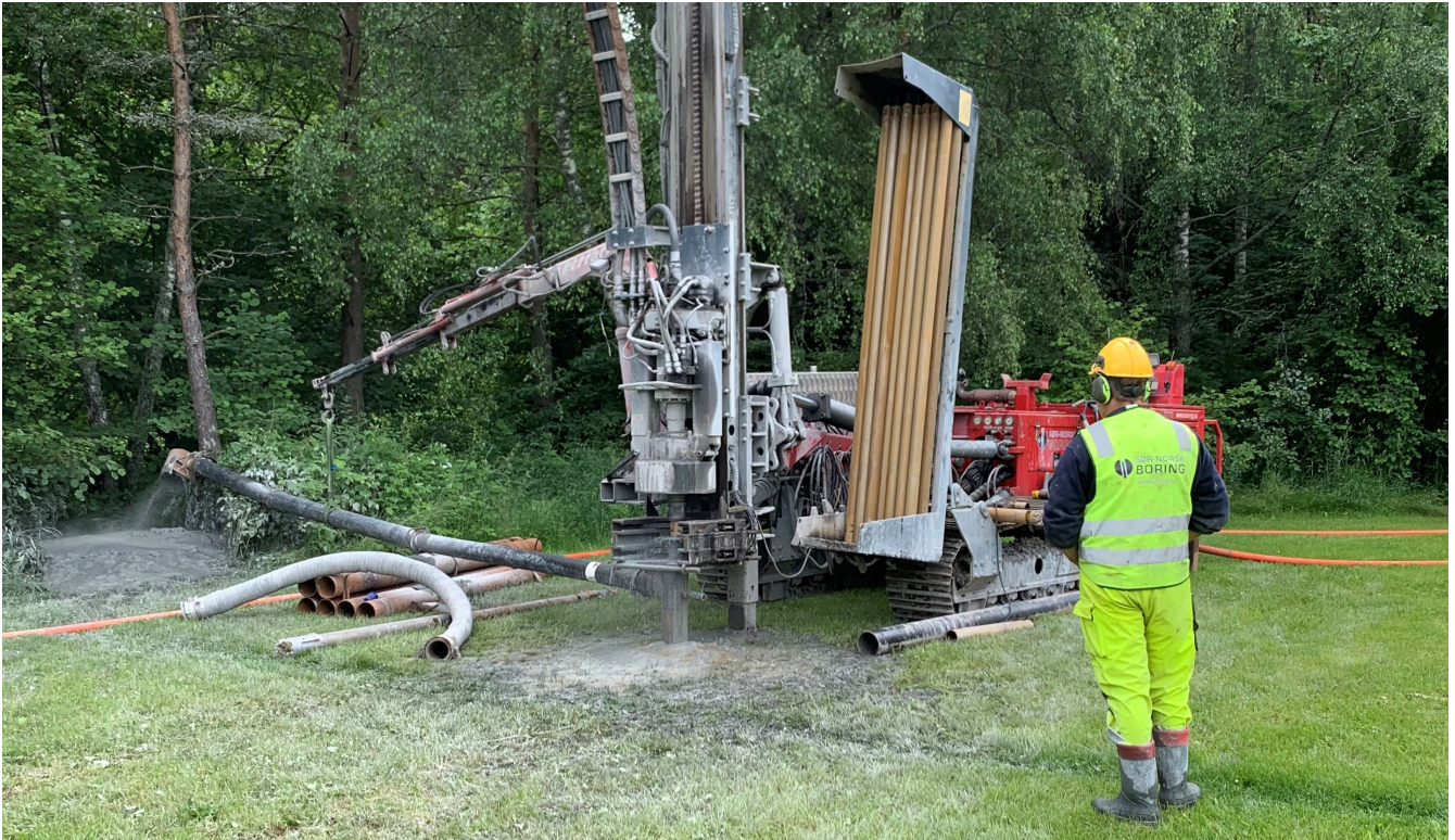
Boring av testbrønn
