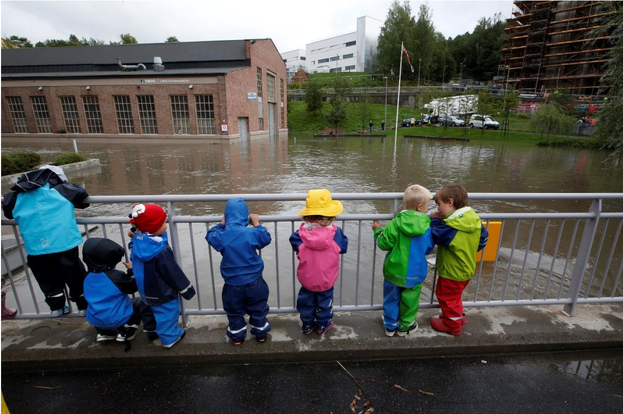
Bilde 2 Nedre del av Alnaelva går i kulvert under bakken. I 2015 flommet Alnaelven over på grunn av kraftig nedbør, og vannføringssystemet klarte ikke å ta unna vannet, noe som skapte oversvømmelse i den nybygde Kværnerbyen. Foto: Vidar Ruud/ NTB Scanpix.
