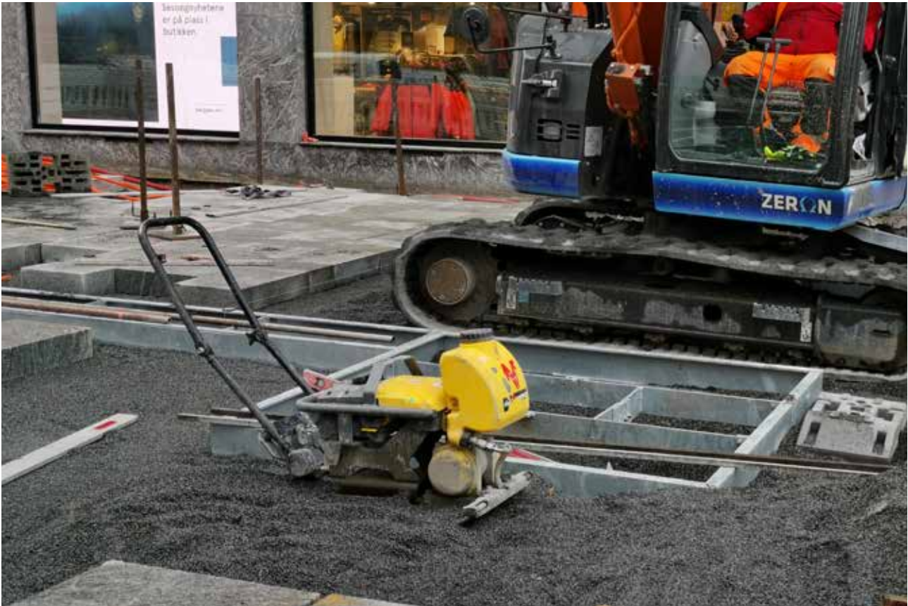
Figur 15 Elektrisk vibroplate Wacker Neuson AP1850e
