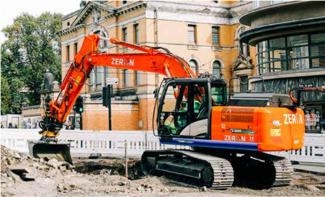
Figur 8 16-tonns gravemaskin Zeron ZX160 med kabelfeste i overvogn
